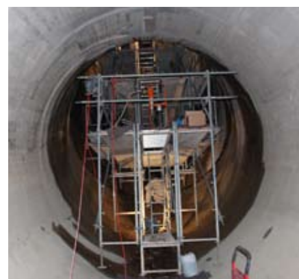
Gerüstkonstruktion im Umlenkkrümmen
