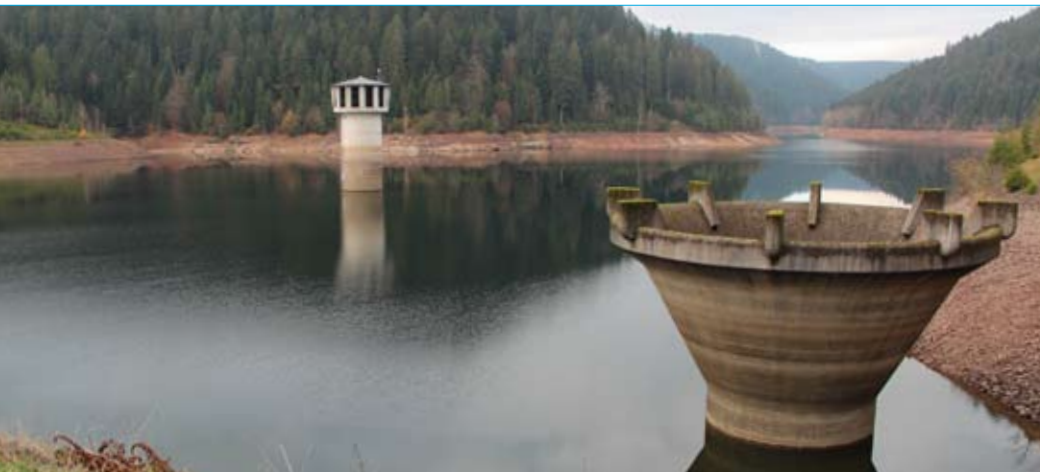
Talsperre im November 2014
