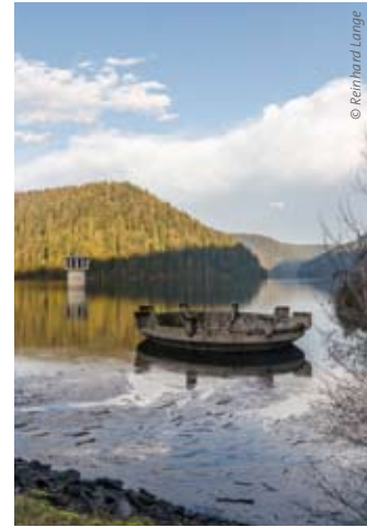
Talsperre nach Sturmtief „Burglinde“
