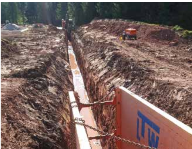
Leitungsbau Sulzhau Freudenstadt
