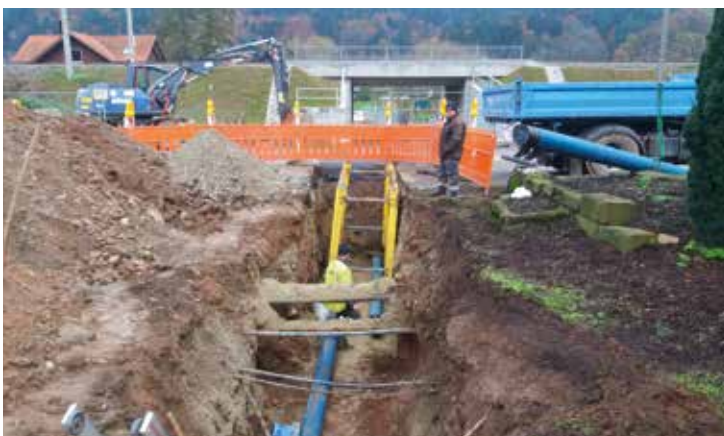
2. Bauabschnitt EÜ Hausach
