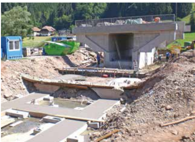
Brückenbauwerk EÜ Gutach
