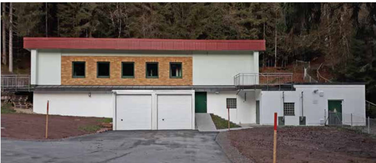
Wasserwerk Lohmühle Loßburg
