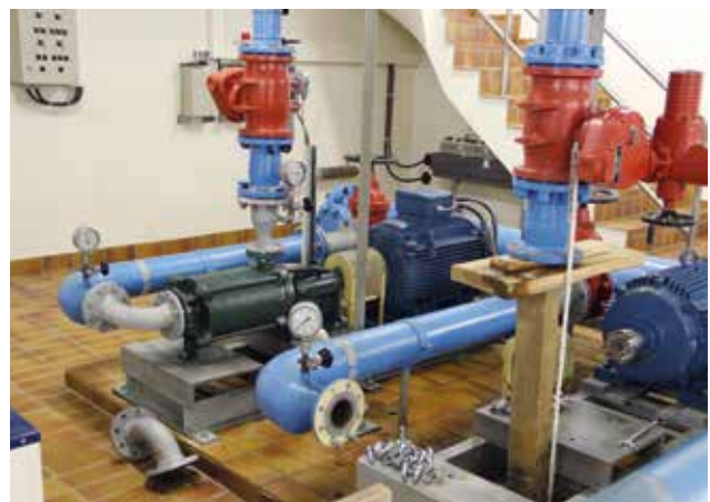
Reparatur Förderpumpe Stollengrund
