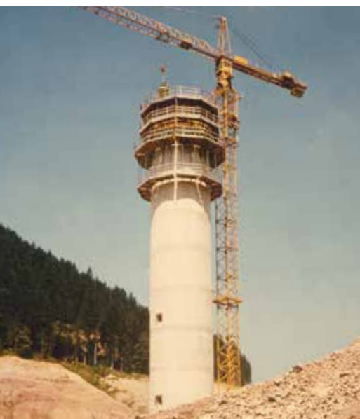
Bau Entnahmeturm
