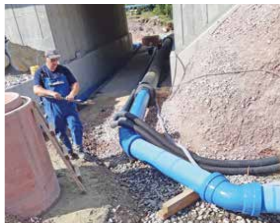
Leitungseinbindung EÜ Gutach
