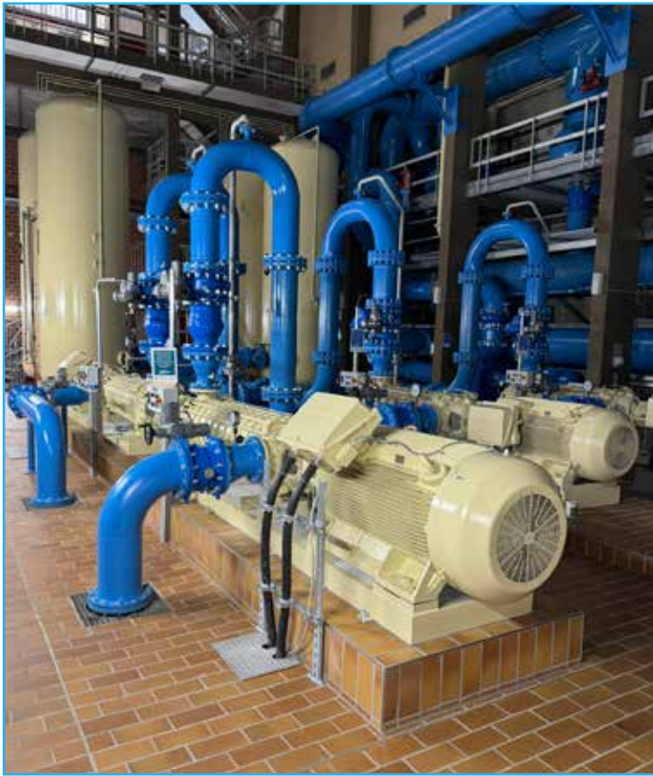
Förderpumpensätze Wasserwerk
